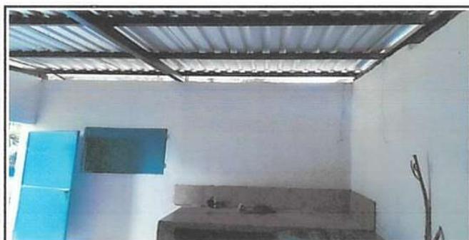
Foto 5: Reparación de sistema electrico con puesta de 2 plafoneras, 3 tomacorrientes, 2 apagadores y una caja de Flipp-on para la cocina.
