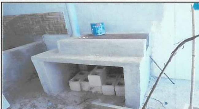
Foto 2: Reparación de estufa rural con chimenea con monocapa blanco y pintado.
